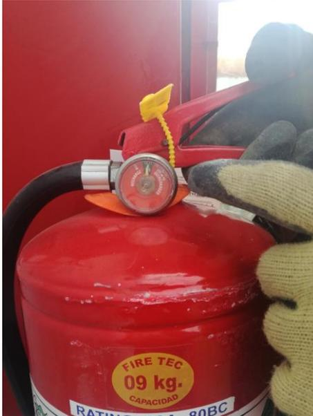
**Paso N° 4.-** Verificar que la aguja **de color amarillo** indicadora de los manómetros en los extintores de PQS se mantenga en posición verde (195 PSI).
