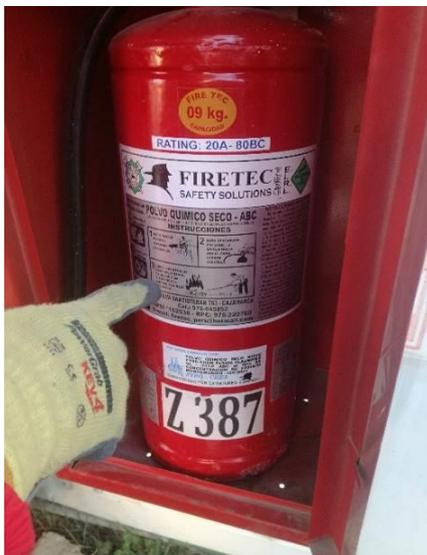
**Paso N° 6.-** Verificar el estado del instructivo de uso del extintor, pictograma para el tipo de fuego a utilizar, rating, capacidad y número de asignado al extintor.
