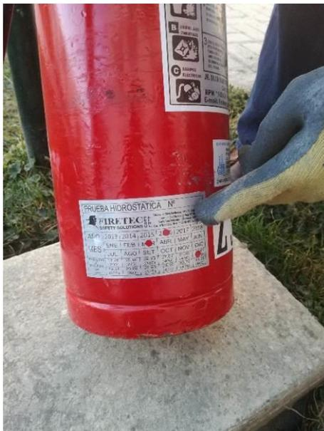
**Paso N° 8.-** Verificar y registrar en el formato de Inspección Mensual de Extintores (SSYMA-PR03.09-F31), la última fecha de prueba hidrostática, señalada en el stickers ubicada en la parte posterior del extintor.
